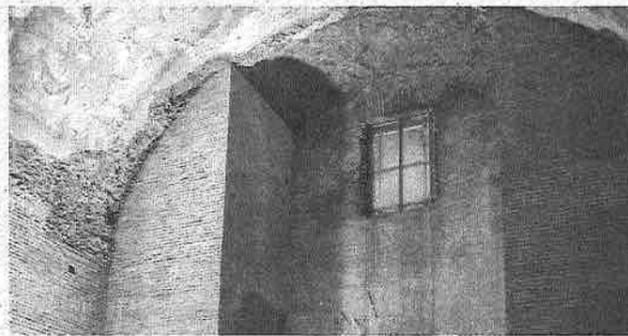
**Interventi** La volta e la Sala delle Civette della Domus Aurea nel corso dei restauri. A destra: consolidamento della struttura, che si è adattata a un microclima con il 90 per cento di umidità
